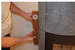
**16a:** Lossa sidostenarna en åt gången och justera in dem så att de är plana med toppstenen – spänd därefter sidostenen igen.
