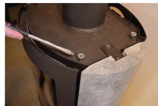
**3:** Afmonter de 4 el. 5 møtrikker, der er monteret på toppen af råovnen - smid dem ikke væk - de skal anvendes under punkt 21!
