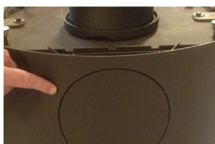
**6:** Jos haluat savuputken lähdön takaan taakse, irrota takan yläosassa oleva valurautainen holkki. Ulkokuoren ja lämpökivilven levyt väännetään varovasti irti. Takkaan asennettu peittolevy irrotetaan (se on otettava ulos tulipesän kautta) ja asennetaan sitten takan yläosaan valurautaholkin paikalle. Valurautaholkkia asennetaan takan takapuolelle. Muista tiiviste.
