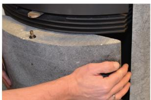
**23:** Montera de 2 st. medföljande packningarna på undersidan av täljstenen. Rengör först stenen där packningen ska klisters fast. Avlägsna plastpropen i botten av kaminen.
