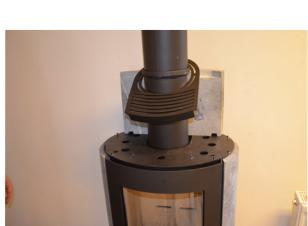
**11:** Montera nu den bakre täljstenen (Observera att front- och baksten är identiska, så om du tycker att den ena stenen är "finare" än den andra, ska du montera den "fina" stenen fram och den andra bak). I underkanten av stenen finns 4 hål som ska passa ner i de 4 motsvarande styrtapparna på stålplattformen.
