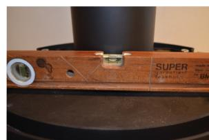
**7:** Tarkista, että takka on vaa'assa. Asenna takan alle tulevat 4 jalkaa, ja säädä niitä mikäli tarpeellista siten, että takka on tukevasti ja varmasti jalustallaan.
