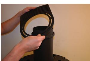
**10:** Såfremt du monterer ovnen med en topmonteret stålskorsten, og ønsker at installere skorstenen INDEN du færdigmonterer din ovn, så skal du huske at montere topstenen. – Den kan IKKE eftermonteres! Monter skorstenen til sidst.
