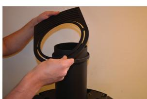
**10:** Om du monterar kaminen med en toppmonterad stålskorsten och önskar installera skorstenen INNAN du färdigmonterar din kamin, måste du komma ihåg att montera toppgallret. – Det kan INTE eftermonteras. Montera slutligen skorstenen.
