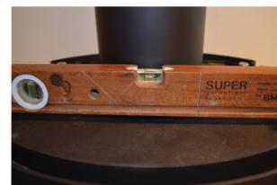
**7:** Sjekk at ovnen står i vater. Monter/juster de fire justeringsføttene under ovnen om nødvendig, slik at den står stabilt og trygt på underlaget.
