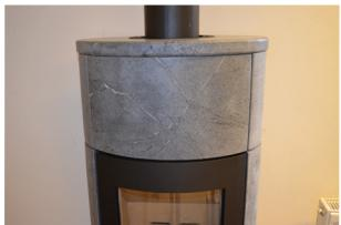
**21:** Montera de 4/5 muttrarna på låsbrickorna. Skruva dem så långt ner som möjligt så att topptäljstenen ligger ner mot täljstenen och horisontellt.
