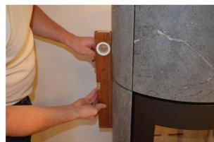
**16a:** Løsn sidestenene én ad gangen og juster dem ind, så de er plan med topstenen – spænd herefter sidestenen igen.
