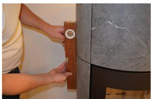
**16a:** Löysää sivukivet yksi kerrallaan ja sovita niitä siten, että ne ovat tasassa päälyskiven kanssa – ja kiristää sivukivet uudelleen kiinni.
