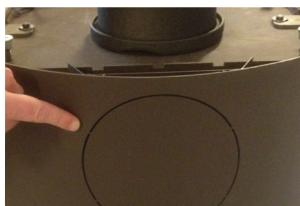
**6:** Ved ønsket bakrør, fjern støpejernsstussen på toppen av ovnen. Platene bak på ytterkappen og varmeskjøldet, brekkes forsiktig ut. Dekkplaten, som er montert på ovnen, demonteres (må tas ut gjennom brennekammeret) og monteres deretter på toppen av ovnen istedenfor støpejernsstussen. Støpejernsstussen monteres på baksiden av ovnen. Husk pakning.
