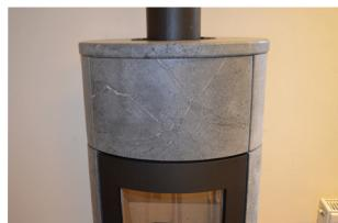
**21:** Monter de 4/5 møtrikker på låsebrikkerne. Skru dem så lang ned som muligt så topfedtstenen ligger ned mod fedtstenen og i vatter.
