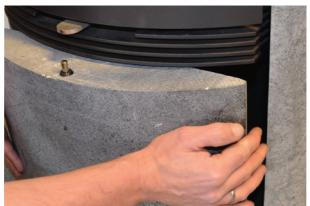
**23:** Asenna mukana tulevat 2 tiivistettävä vuolukiven alapuolelle. Puhdista ensiksi kivi siitä, mihiin tiiviste liimataan kiinni. Poista takaa pohjalla oleva muovitulppa.
