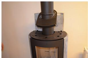
**11:** Monter nu den bageste fedtsten (Bemærk front- og bagsten er identiske, så hvis du synes den ene sten er "pænere" end den anden, monterer du den "pæne" sten forrest og den anden bageste)
