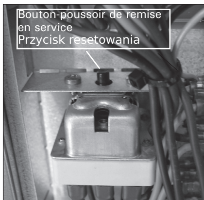
Figure 3. Protection contre la surchauffe Rysunek 3. Bezpiecznik termiczny
