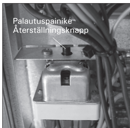
Kuva 3. Ylikuumenemissuoja Bild 3. Överhettningsskydd
