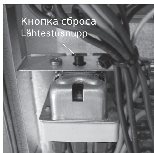
Рис. 3. Защита от перегрева Joonis 3. Ülekuumenemiskaitse
