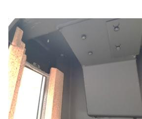
**6:** Lossa på de fyra skruvarna med en 4mm insexnyckel (se bild 1). De två nedre rökvänderhylorna i metall skjuts något bakåt så att de enkelt kan avlägsnas. Brännkammaren och rökkanal är nu klar för rengöring.
