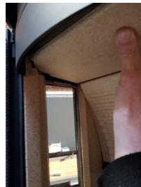
**2:** Die obere Rauchumlenkung wird vorsichtig über die beiden Vermiculite-pfosten im Kaminofen gehoben.
