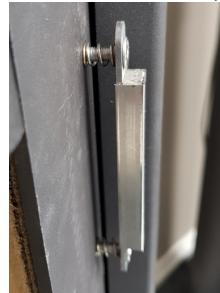
For å endre trekk i døren, justeres de to magnetmoduler.
