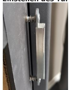
Um den Widerstand in der Tür zu ändern, werden die beiden Magnetmodule eingestellt.
